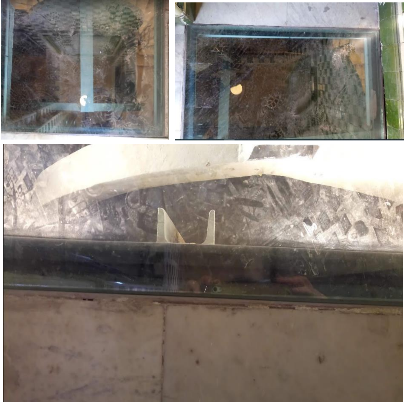
Detalle de la puerta de acceso del montacargas de planta baja de la Confitería.
