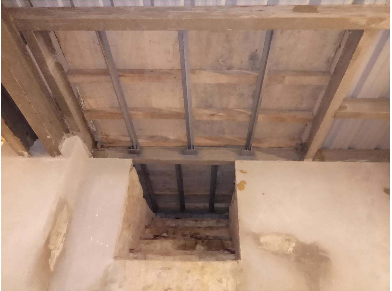
Detalle de vano para puerta de acceso de servicio y escalera desde el segundo subsuelo.
